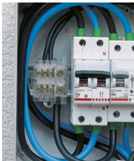
Ejemplos de uso de regletas de bornas tipo Z16-8D y Z6-6D dentro de centralitas para equipos de módulo DIN
