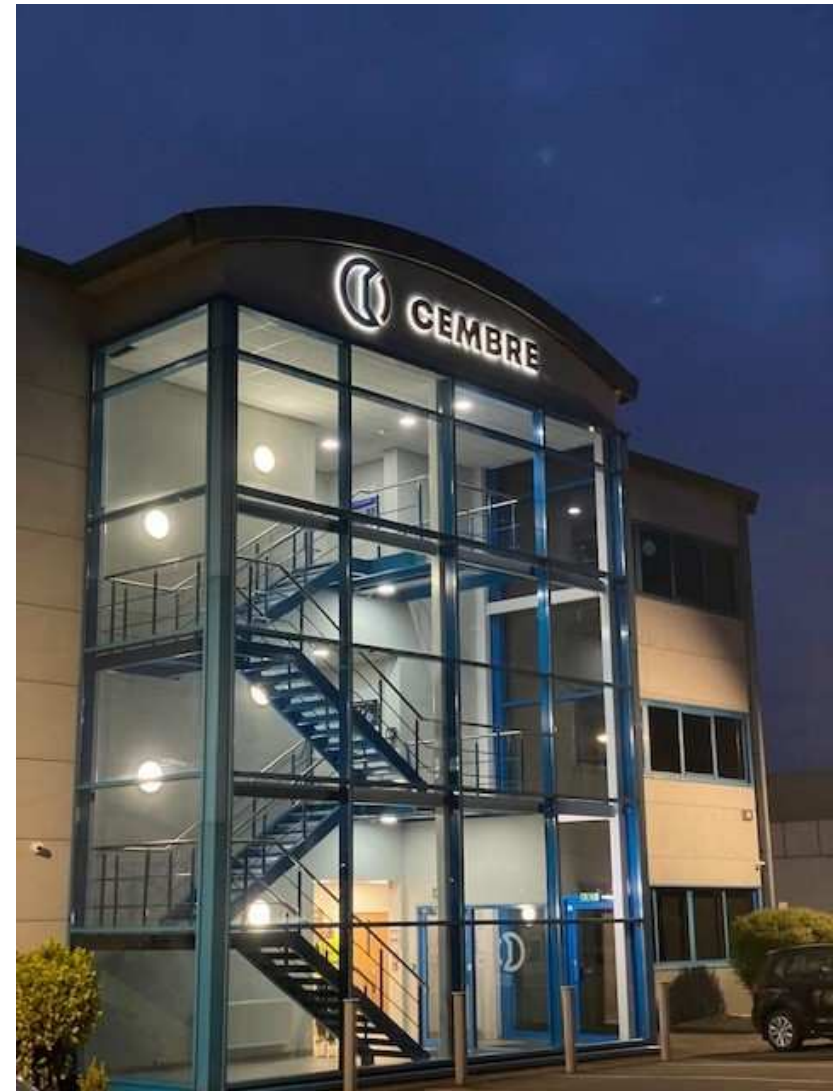
CEMBRE Ltd. – Stabilimento a Curdworth Birmingham (UK)
