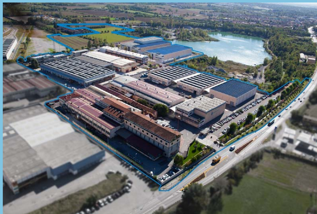
Cembre S.p.A. – Headquarter a Brescia (Italia)
