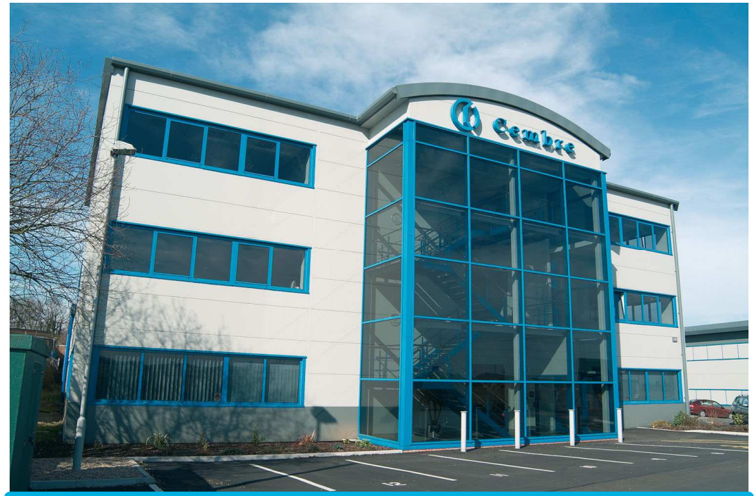
CEMBRE Ltd. – Stabilimento a Curdworth Birmingham (UK)
