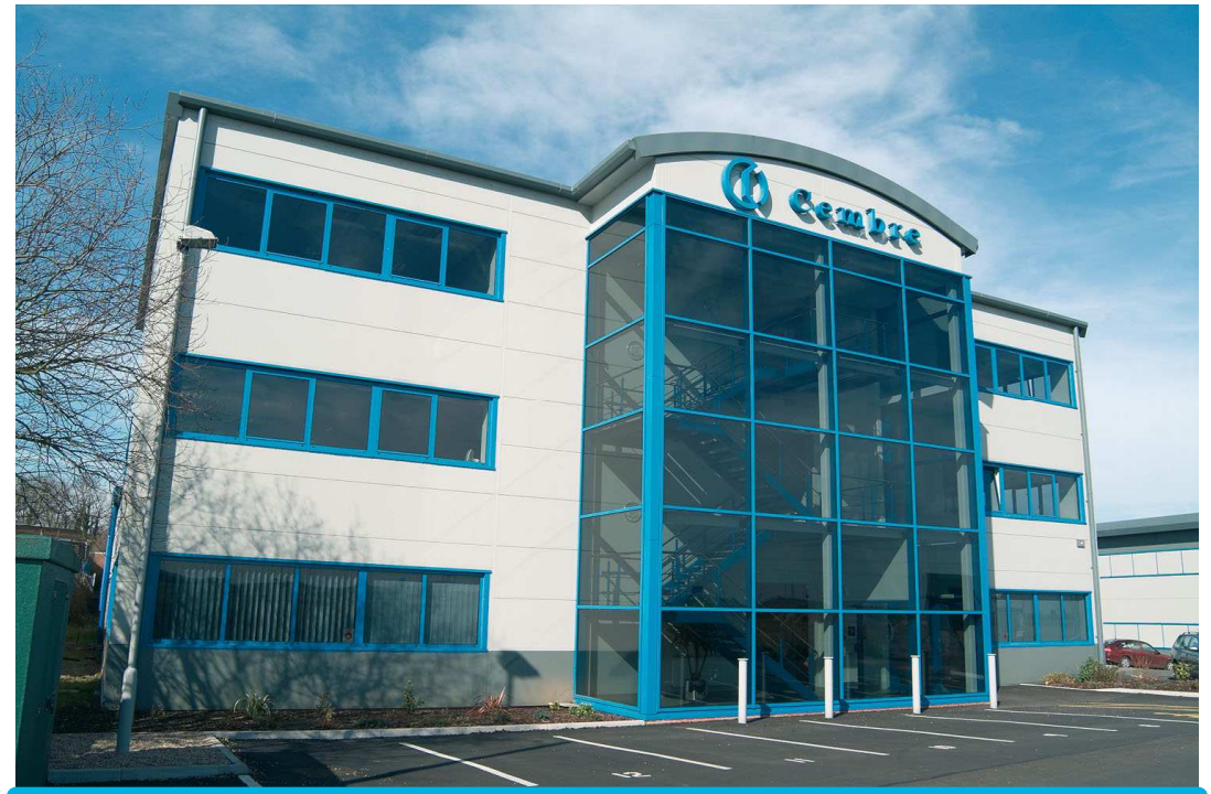
CEMBRE Ltd. – Stabilimento a Curdworth Birmingham (UK)
