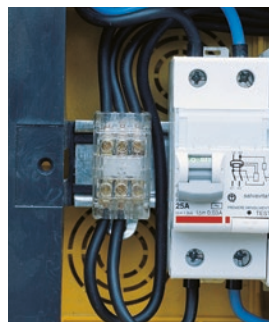
Esempi di utilizzo delle morsettiere tipo Z16-8D e Z6-6D all'interno di centralini per apparecchi modulo DIN
