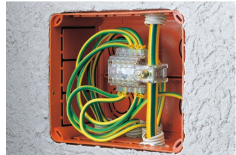
Esempio di utilizzo delle morsettiere tipo Z35T-11 senza interruzione del montante come nodo equipotenziale di terra
